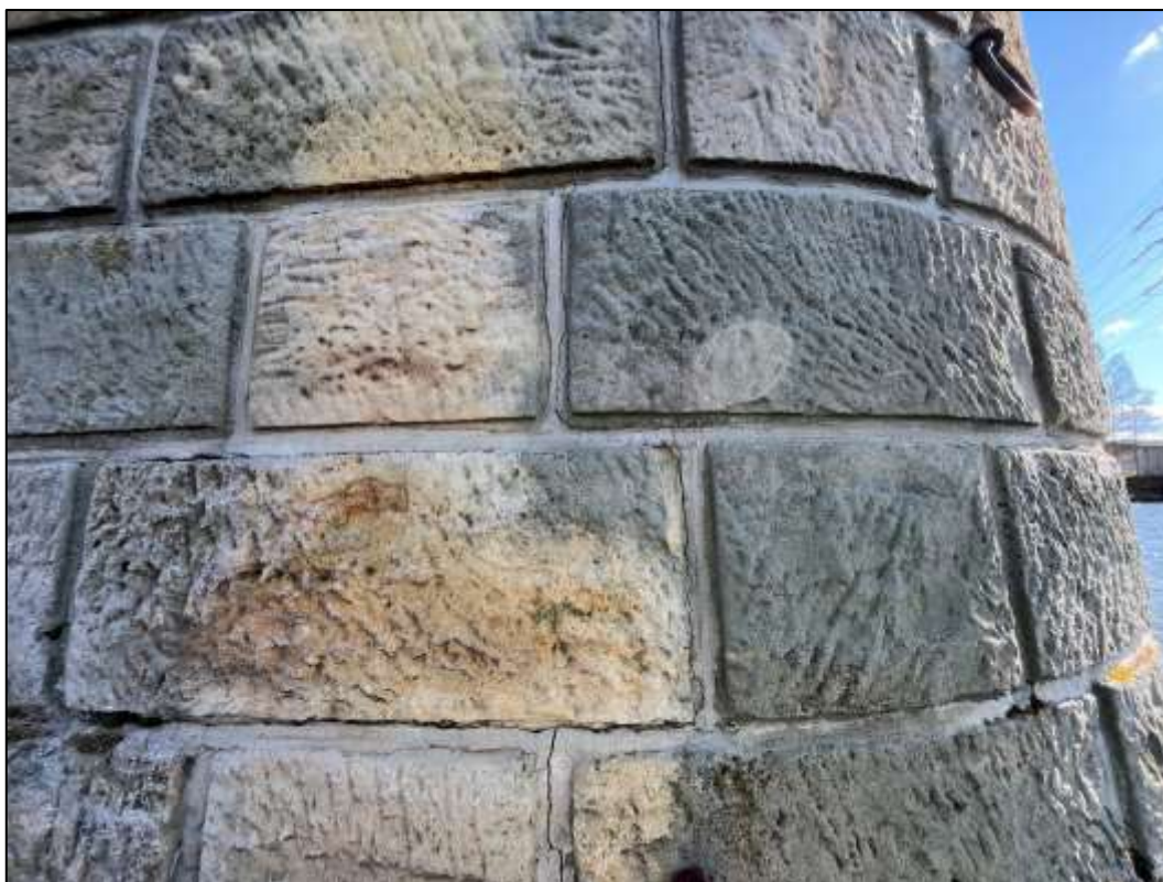
Foto 28: Narušené spárování na čele pilíře na povodní straně.
