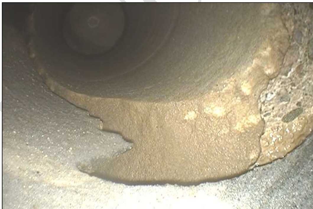
Foto 16: Typická kaverna ve zdivu na rozhraní vnějšího a vnitřního zdiva pilíře
