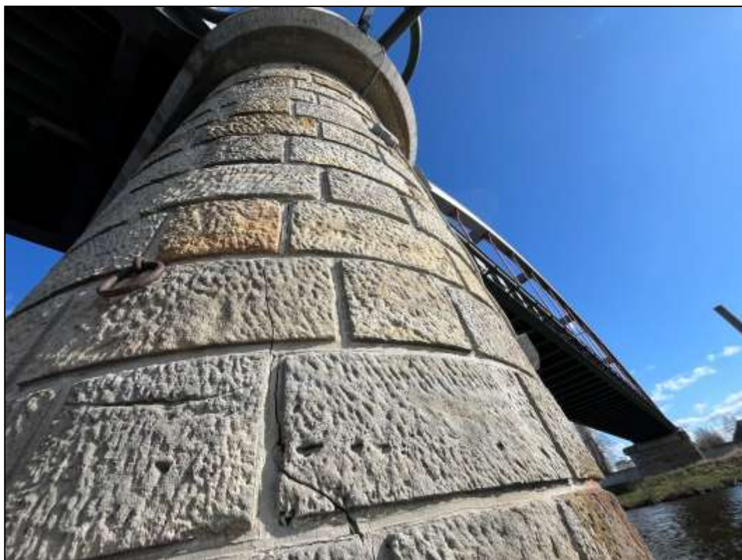
Foto 26: Trhlina na čele pilíře na povodní straně
