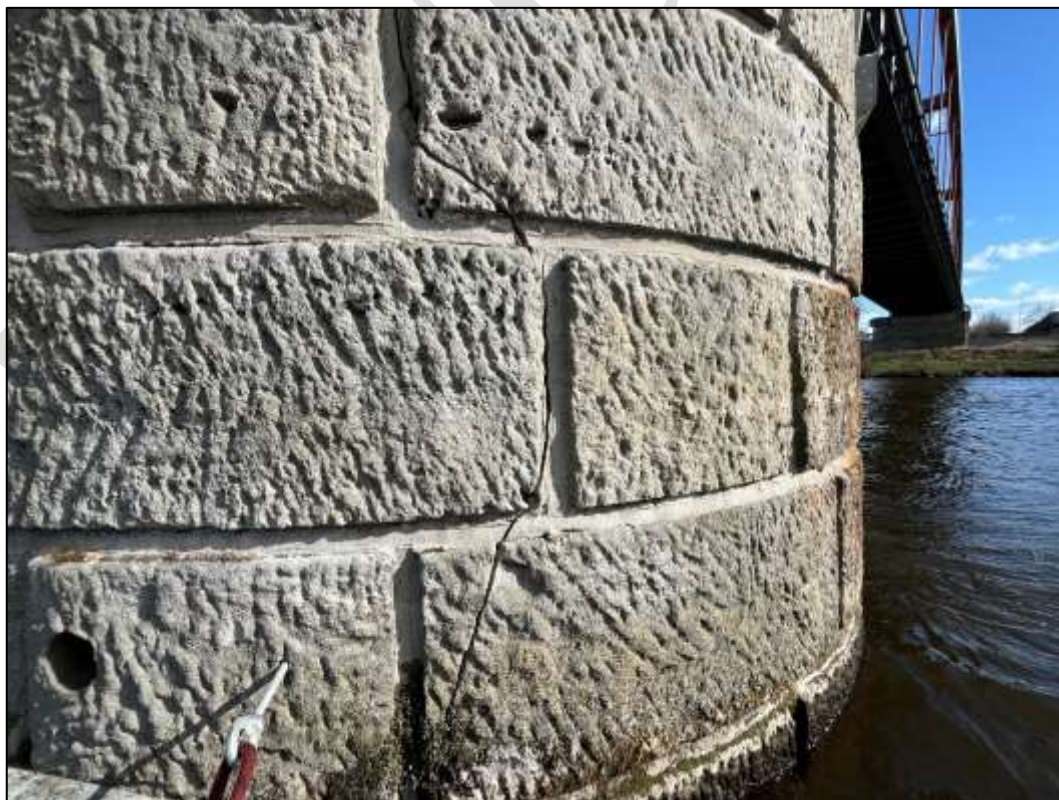
Foto 27: Trhlina na čele pilíře na povodní straně
