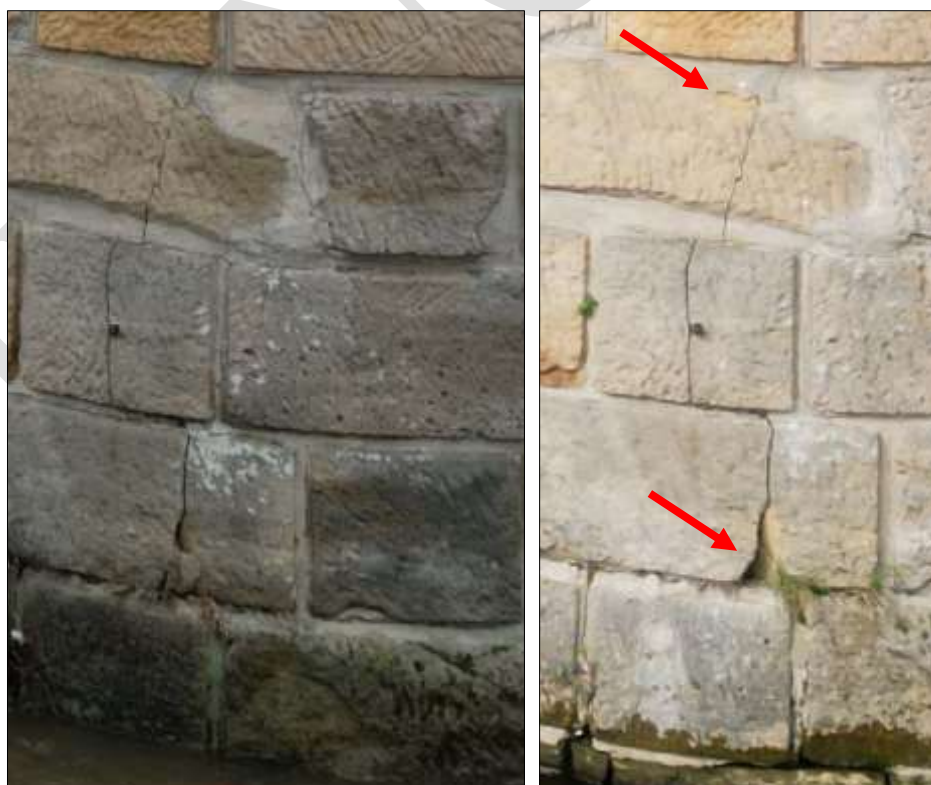
Foto 34: Čelní strana, změna stavu – staré (vlevo) – nové foto, poloha viz červená značka, patrné odpadnutí volných částí zdiva
