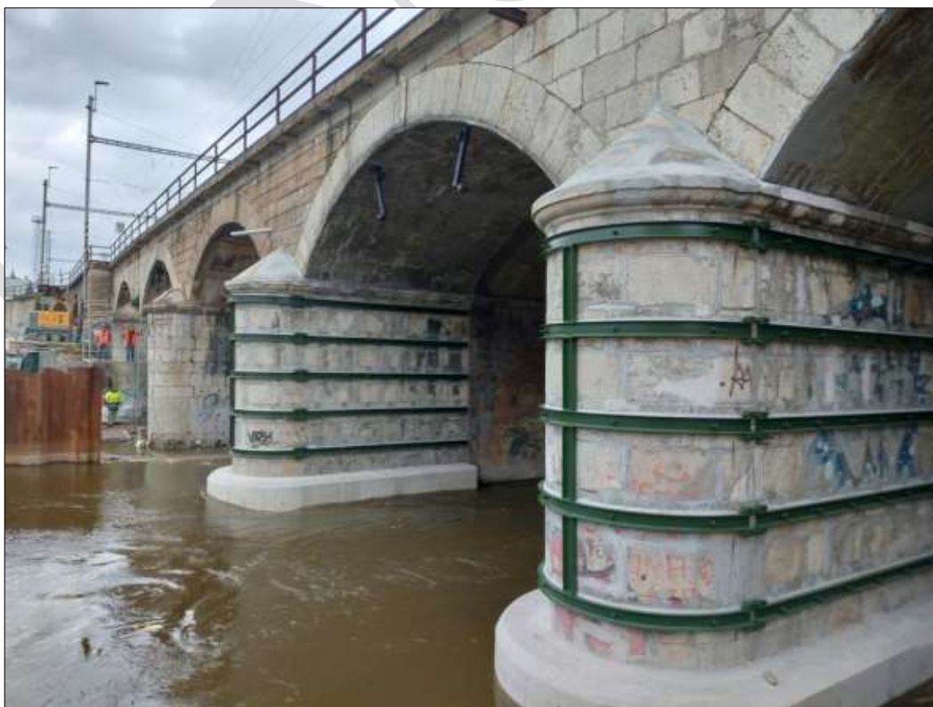
Foto 39: Most v Brně, Opuštěná ulice – zesílení popraskaného pilíře
