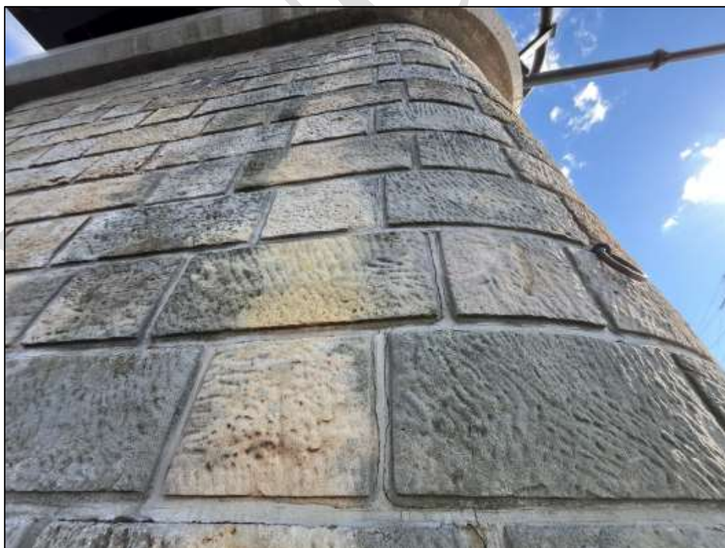
Foto 29: Narušené spárování na čele pilíře na povodní straně.
