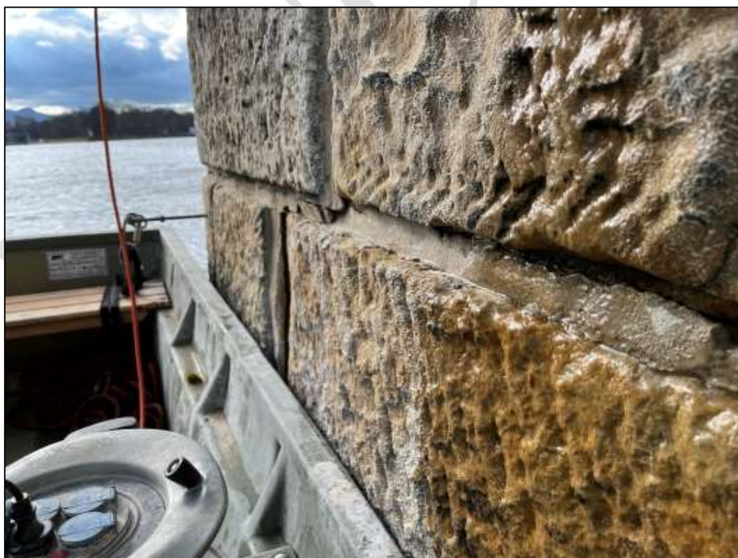
Foto 25: Vytékání vody ve sparách při provádění VTZ.
