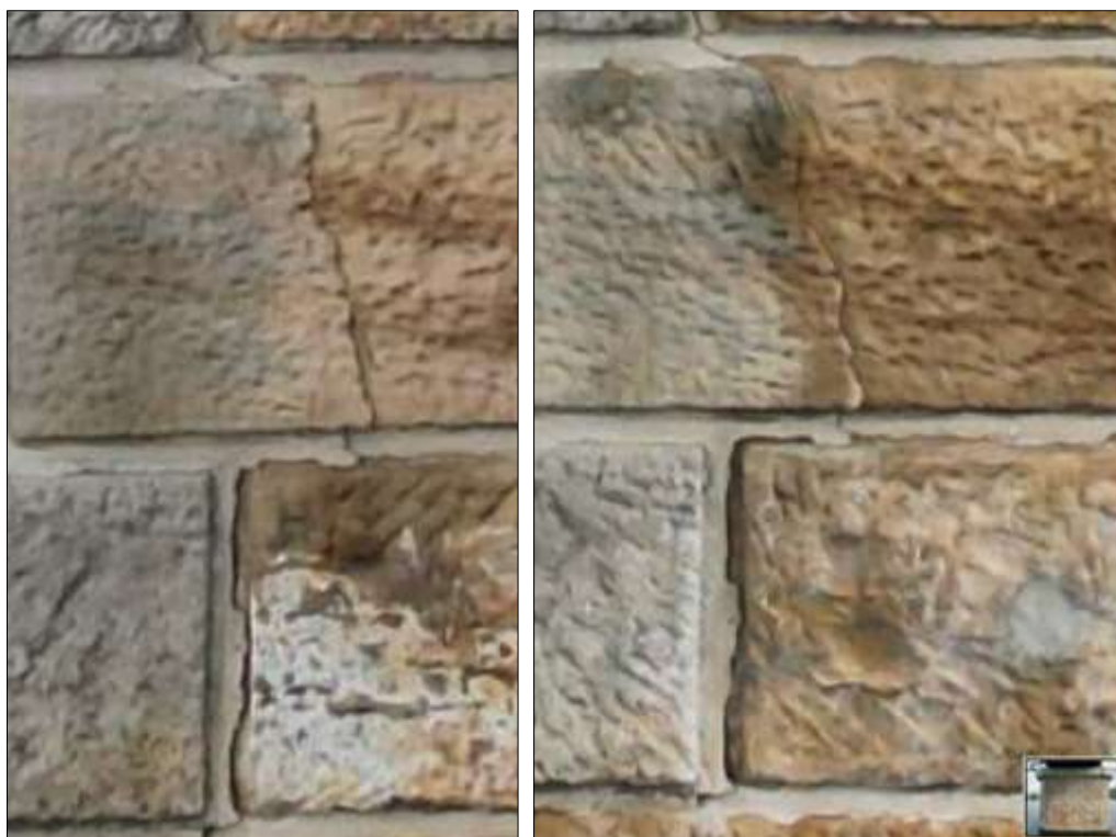
Foto 32: levá strana, změna stavu – staré (vlevo) – nové foto, poloha viz červená značka, bez zjevných změn, rozdíly mohou být dány stínem – tenké trhliny jsou v zásadě konstantní
